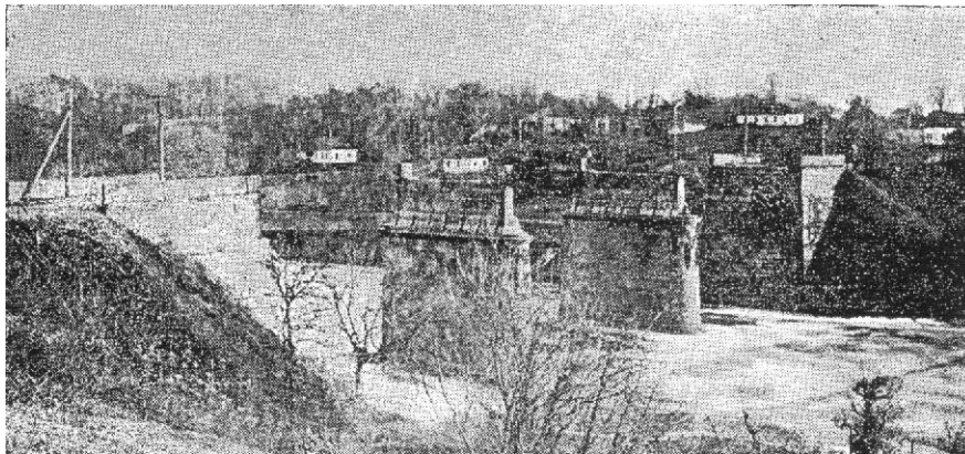
Разрушенный мост на Житомирской улице после погромов в 1919 г.
